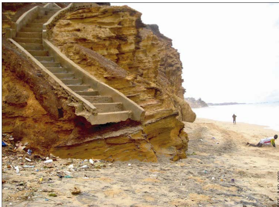
Photo 10 : Falaise vive d'une dizaine de mètres d'altitude taillée dans les grès maestrichtiens. On distingue nettement le pied de falaise et le sommet de falaise habituellement utilisés comme lignes de référence dans ces types de littoraux. Vue prise au sud de Yène-sur-mer en direction du sud, le 05-08-2007.
